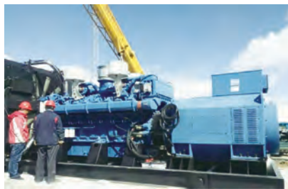
玉柴YC16VC发电动力服务世界最长的高原冻土公路隧道鄂拉山隧道建设
