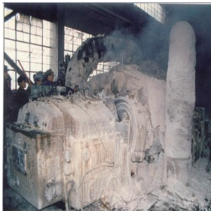
图7 秦岭发电厂5号机组断轴毁机事故现场
